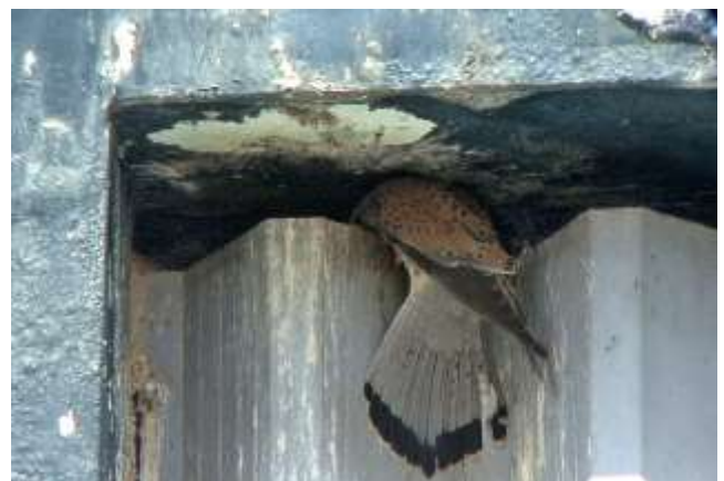
外壁の隙間に営巣中。オスが飛び込んできた。
