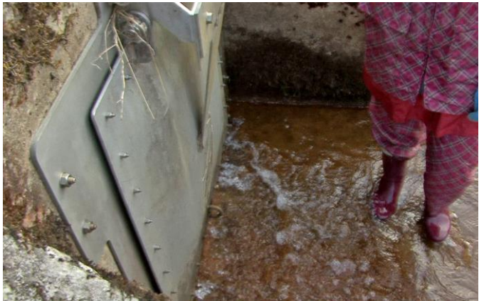
最下流部の逆流防止板。かなり重かった。
