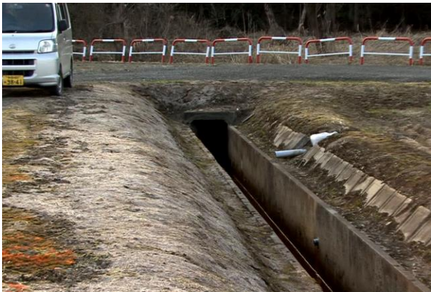
水路の下流部は道路の下を通り、川に通じている。
