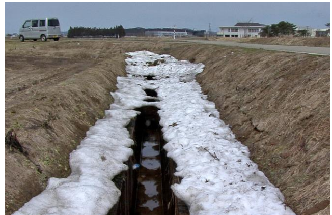
周辺は溶けても、水路を覆う雪はまだ残っている。この上を歩いたのでしょう。
